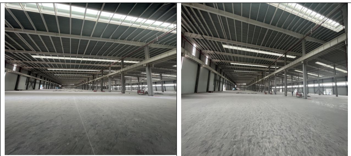
拟建项目厂区现状图
