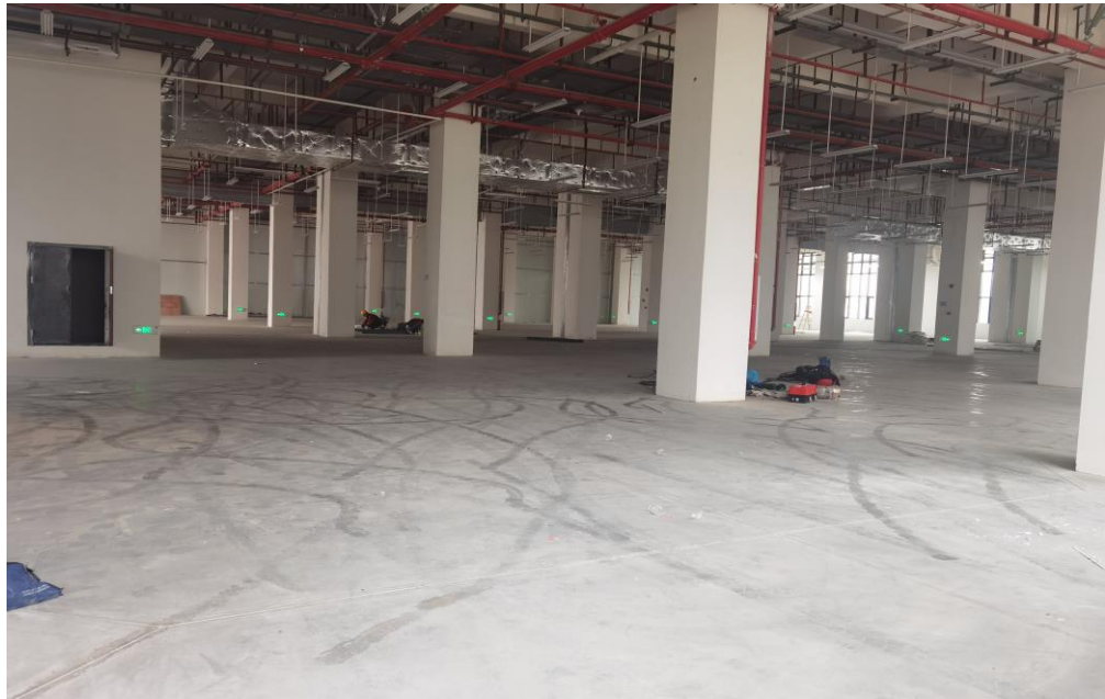
图 2.9-1 拟建项目厂房现状图
