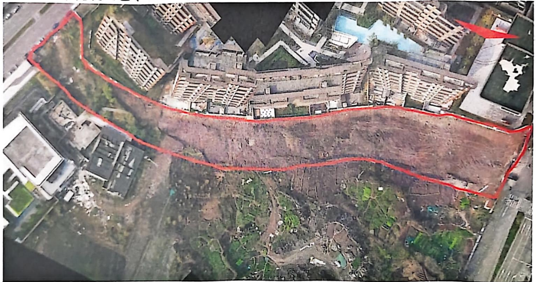
Ah20 路现状（已于 2025 年 1 开工，正在进行路基施工，拍摄时间：2025.1）
