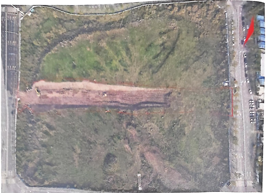
Ah08 路现状（已于 2025 年 1 开工，正在进行路基施工，拍摄时间：2025.1）
