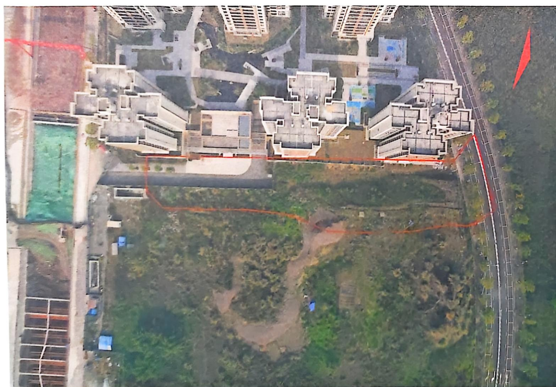
Ah03 路现状（未开工，拍摄时间：2025.1）
